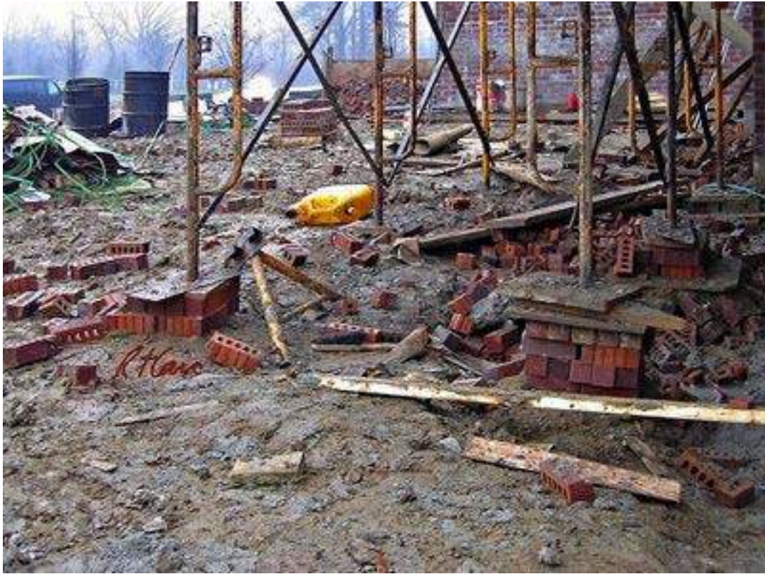
رفتار نایمن در نصب پایه های داربست
