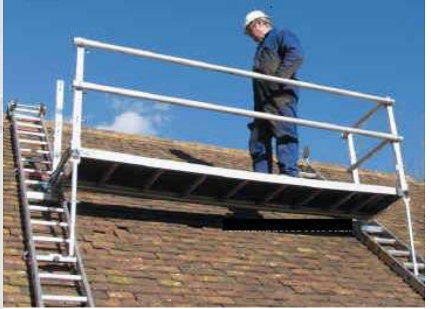
شکل ۳۰- جایگاه کار روی سطوح شیبدار
